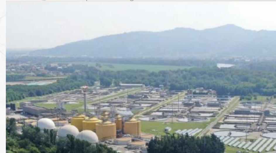
Sito dimostrativo: impianto di depurazione acque Castiglione Torinese
